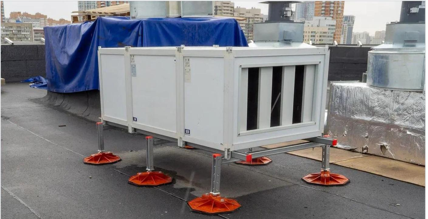
ОБЪЕКТ: Здание Министерства здравоохранения в г. Москва. Разработаны опорные конструкции для климатического оборудования. Объем поставки - 34 комплекта.
